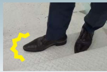
滑りやすい箇所への滑り止め。
