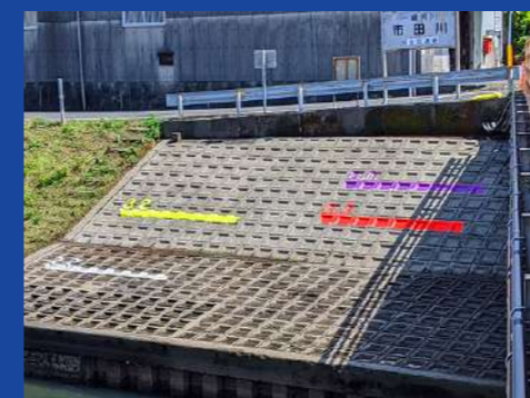
市田川 下田水位観測所
