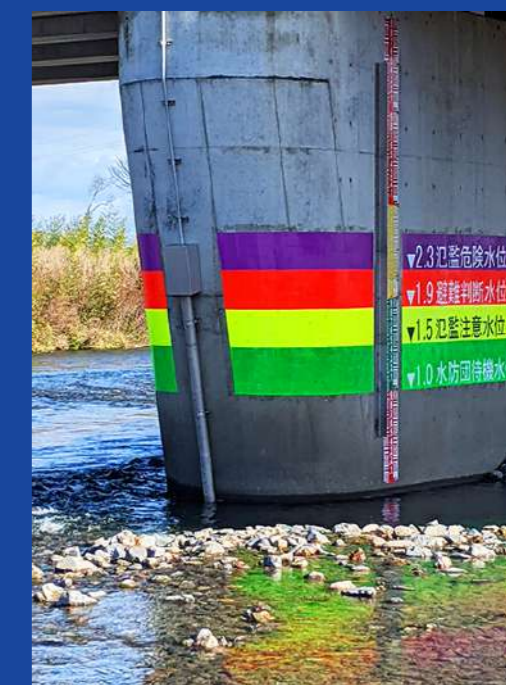
安曇川 常安橋
