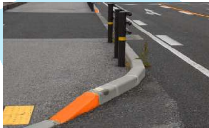
道路の縁石へマーキング#蛍光
