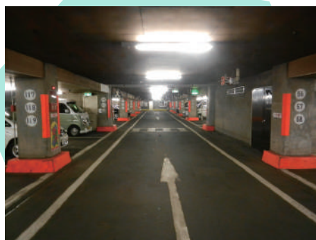
地下駐車場危険箇所表示#蛍光
