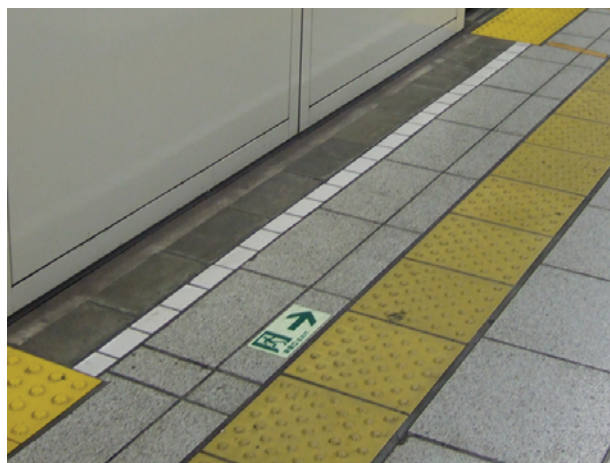
蓄光明示物実績写真
